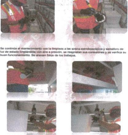
Se continúa el mantenimiento con la limpieza a las sirenas estroboscópica y semáforo de luz de estado limpiándola con aire a presión, se reaprietan sus conexiones y se verifica su buen funcionamiento. Se anexan fotos de los trabajos.
