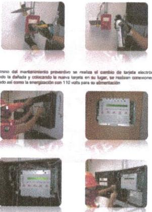
Al término del mantenimiento preventivo se realiza el cambio de tarjeta electrónica, retirando la dañada y colocando la nueva tarjeta en su lugar, se realizan conexiones de cableado así como la energización con 110 volts para su alimentación.
