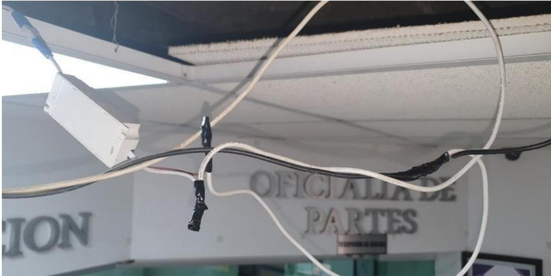
En algunos puntos de la cámara plena sobre el plafón no hay espacio suficiente para la inspección de la instalación eléctrica ya que hay múltiples ductos de aire acondicionado.
