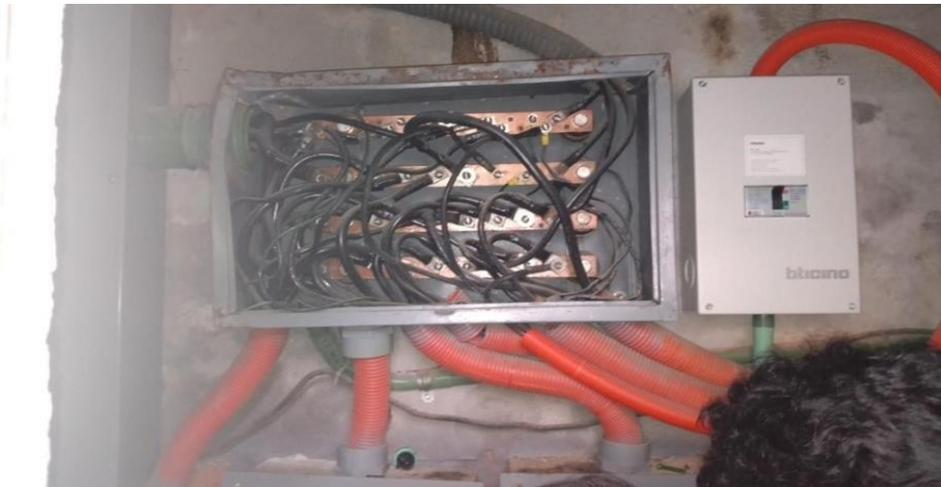
Se observará que en la planta baja y 1er nivel el espacio dedicado a los tableros eléctricos cuente con espacio de trabajo suficiente para su inspección de acuerdo con la sección 110-26 de la NOM, operación y mantenimiento, lo anterior se debe a que esta área fue ocupada por la instalación de unidades manejadoras de aire acondicionado
