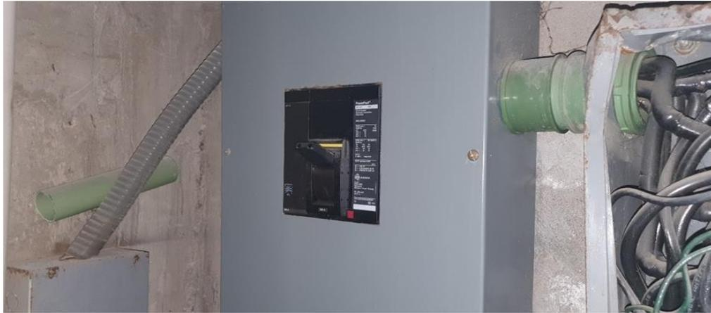
Asimismo, debe de observarse el uso de tubo conduit de polietileno el cual solo está permitido para uso empotrado en concreto (sección 364-3), incluidas las canalizaciones de PVC no cuentan con los accesorios adecuados a la entrada y salida de los envoltentes metálicos (sección 352-46).
