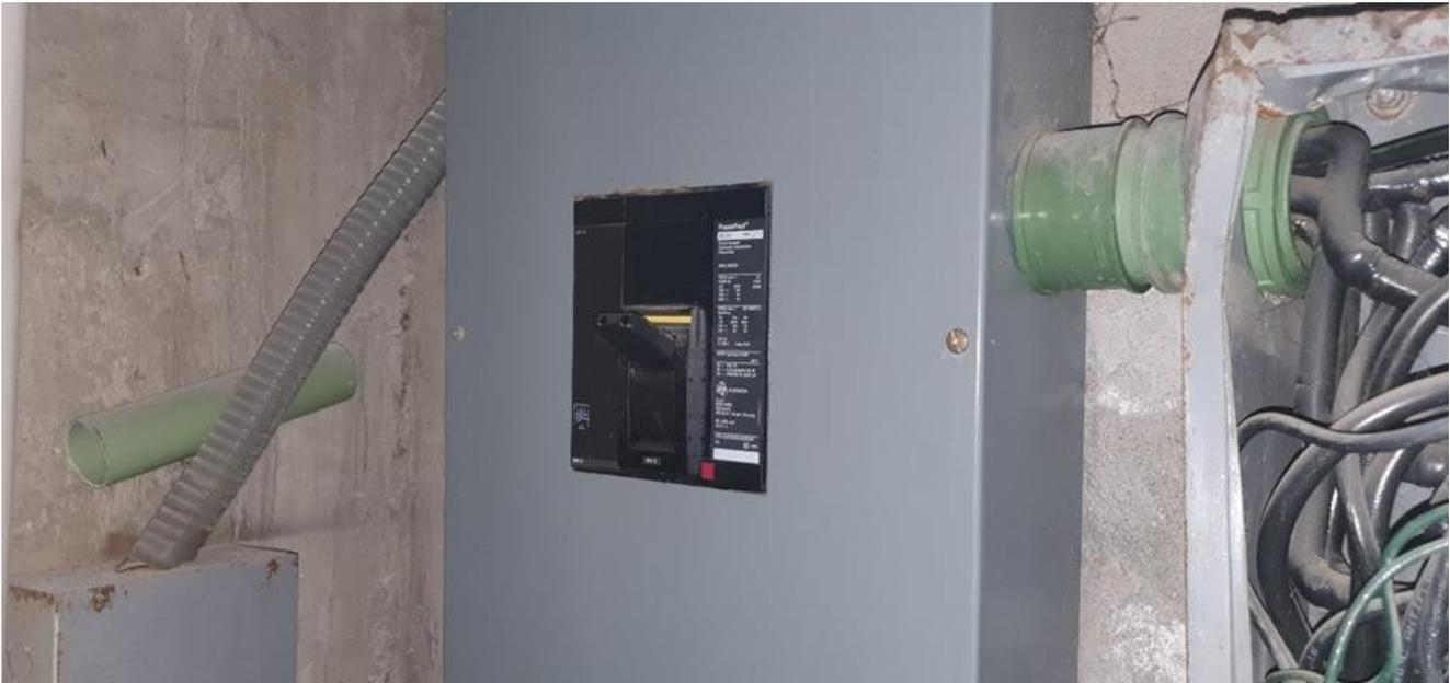
Asimismo, debe de observarse el uso de tubo conduit de polietileno el cual solo está permitido para uso empotrado en concreto (sección 364-3), incluidas las canalizaciones de PVC no cuentan con los accesorios adecuados a la entrada y salida de los envoltentes metálicos (sección 352-46).
