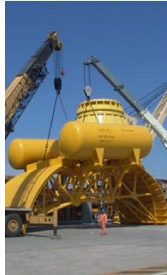
Cargas proyecto heavy lift.
