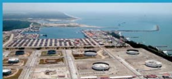
Terminal de Abastecimiento
